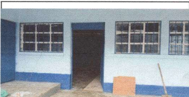
Foto 5: SUSTITUCIÓN DE PISO CERÁMICO UN TOTAL DE 171 m2
