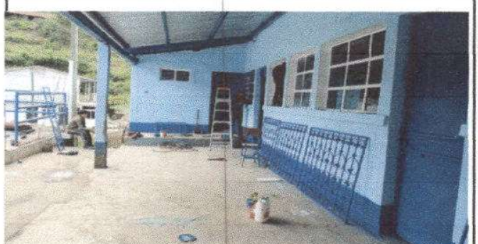
Foto 4: SUSTITUCIÓN DE ESTRUCTURA DE METAL DE VENTANA 11 M2
